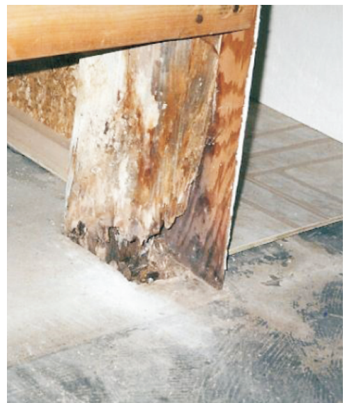
(d) Material Hazard - Wood rot
